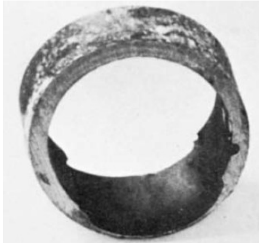
Rysunek 7. Korozja stalowej rury instalacji kondensatu spowodowana obecnością \text{CO}_2 w kondensacie
