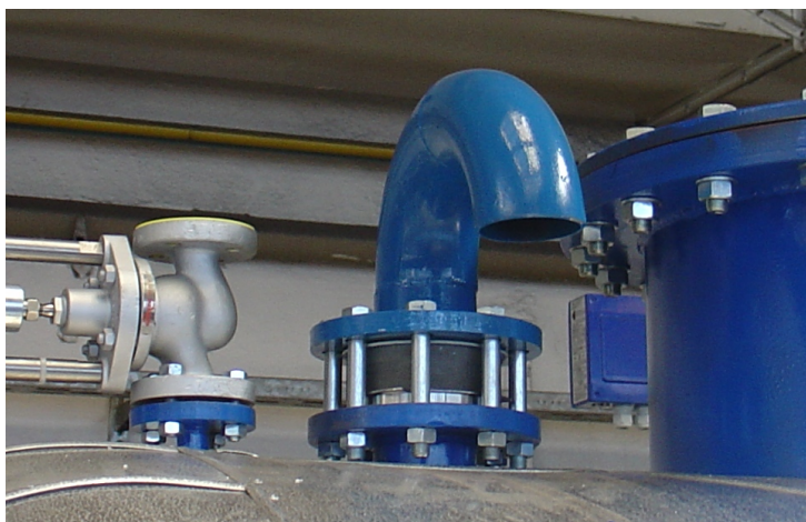
Rysunek 2. Zawór zwrotny jako łamacz próżni na zbiorniku instalacji pary i kondensatu.
